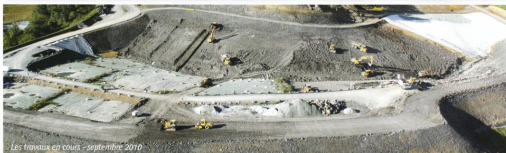
Les travaux en cours - septembre 2010
