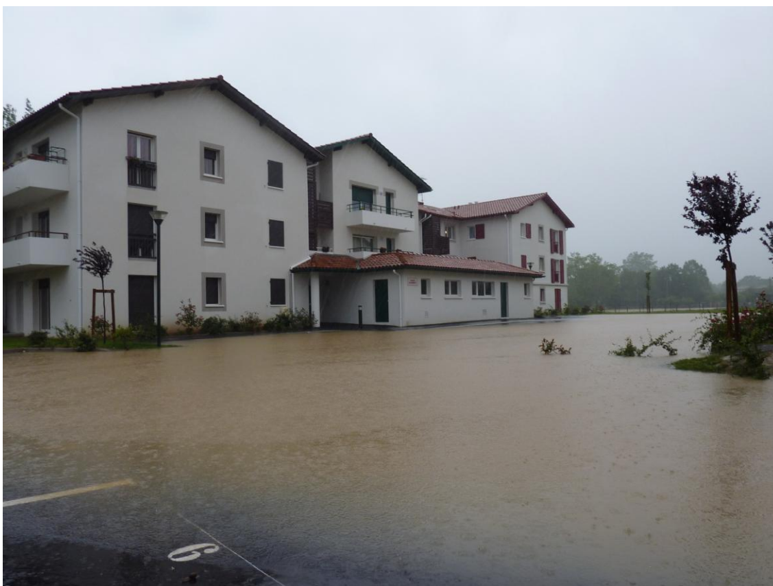
NDLR. 2010-06-07. Photo prise à 9 heures comme la précédente et le niveau de l'eau avait déjà commencé à baisser. Ici, le barrage de Luberria n'a aucun effet, l'eau vient d'ailleurs. Des "logements sociaux" neufs sont sous l'eau dans le quartier du cimetière. Des personnes, à peine installées, dont une invalide, ont dû être évacuées.
